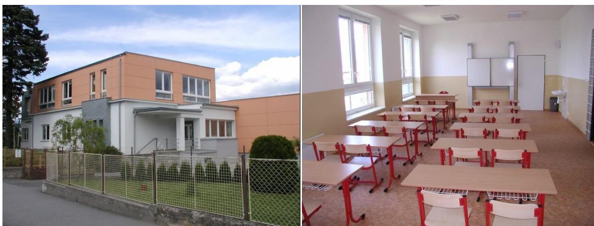
Rekonštrukcia ZŠ Demänovská cesta (exteriér a interiér)
