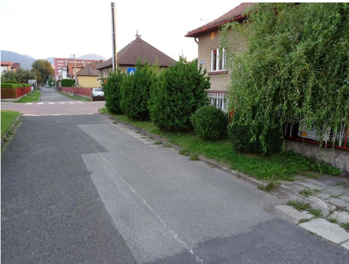
Nekontrolovaná výsadba ulicovej zelene zo strany občanov, ktorá má z pohľadu cestnej bezpečnosti negatívny charakter
